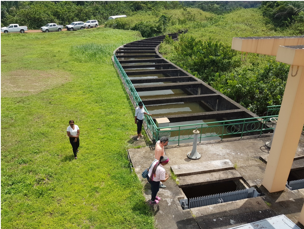
Final del canal y entrada a la cámara de carga de agua de la central
