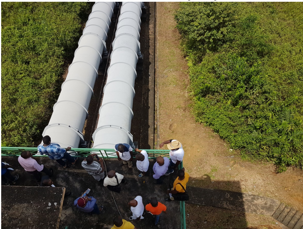
Salida de la tubería forzada desde la cámara de carga
