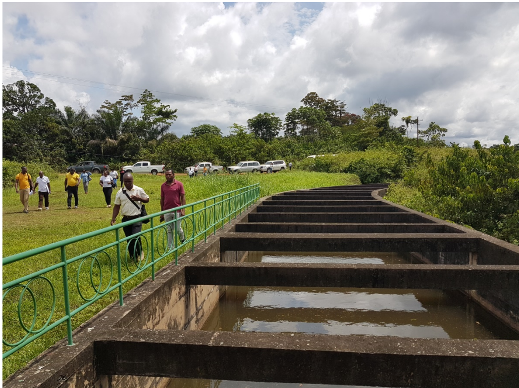
Canal desde el azud a la cámara de carga de agua de la central
